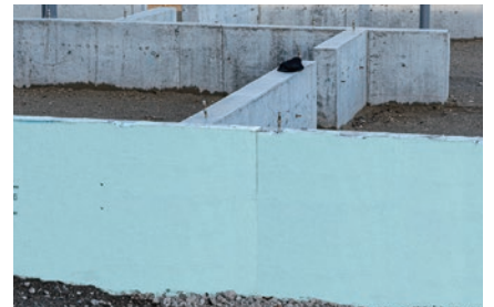
断熱材から侵入
