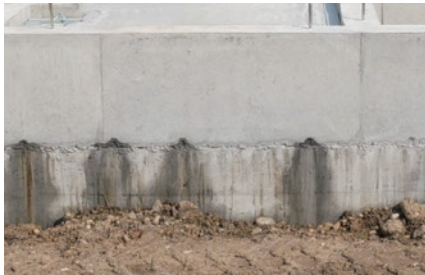
基礎の水抜き穴から
