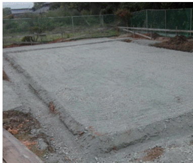
① 砕石敷き込み・転圧
