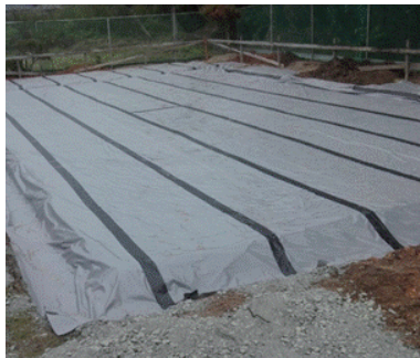
② ターミダンシート敷き込み
